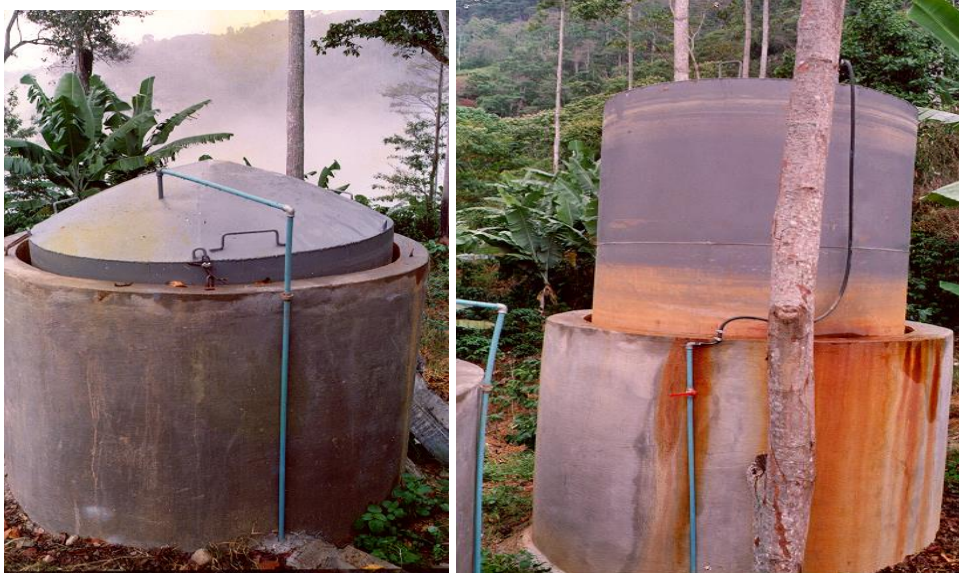
Figura 5. Modelo Biodigestor Bach “Olade Guatemala” y su almacenador “Gasometro”
