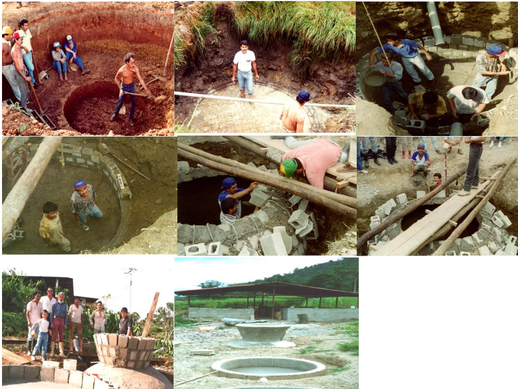
Figura 4. Avance Constructivo del Biodigestor Modelo Chino.
